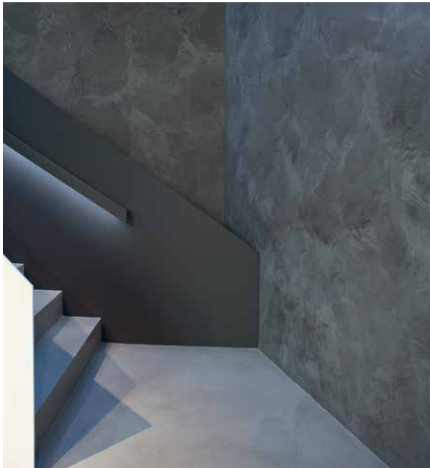
Floor and stairs / Pavimento e scala / Sol et escalier / Boden und Treppe Microtopping
